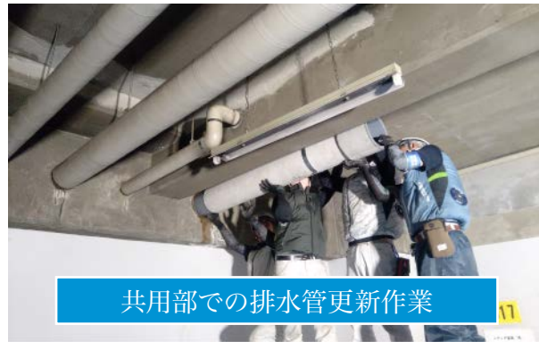
劣化損傷した排水管
